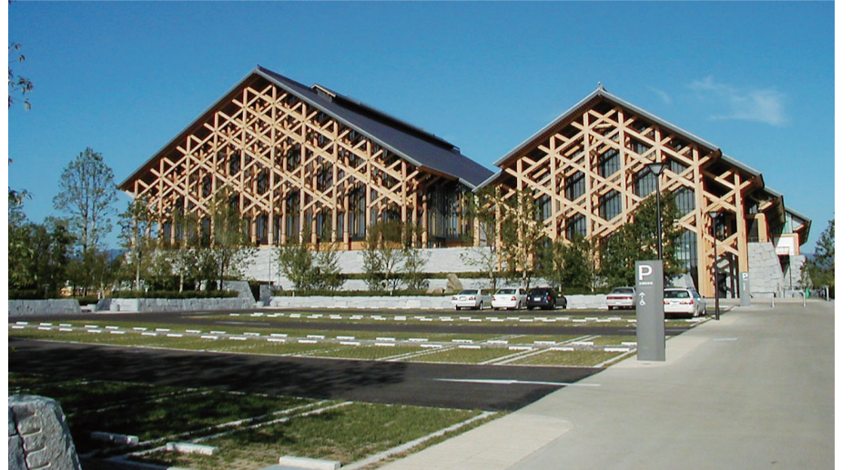
愛媛の木材、瓦(菊間瓦)、石(大島石)、砥部焼を活用した特色ある大会場の「愛媛県武道館」
